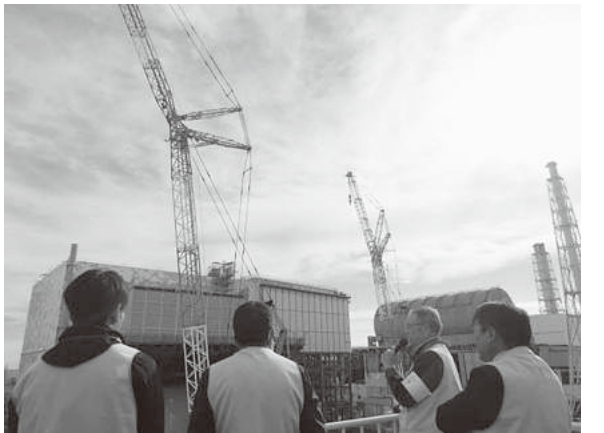
建屋南側に「燃料取り出し用構台」を建設して建屋へアクセスし、燃料を搬出する予定の2号機(左)を見学する仲間
